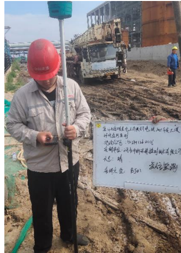
实际钻孔位置
